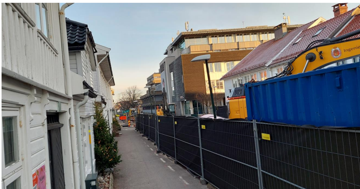
Figur 10 Anleggsarbeider i Rådhusgata, kvartal 29 og 30, desember 2024
