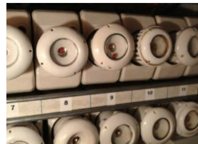
Skrusikringer. Foto: Elsikkerhetsforeningen.
