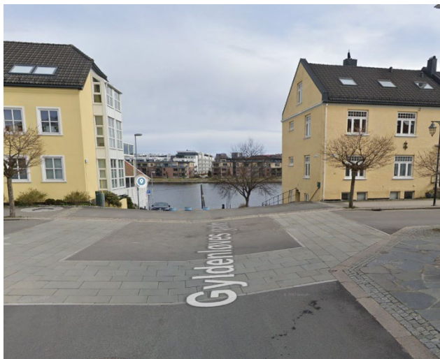
Krysset Elvegata/ Gyldenløves gate. Nedsenket midtparti ivaretar overvannshåndtering. Fra Google streetview.
