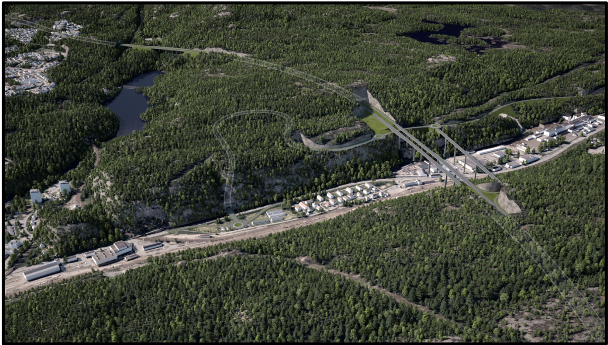
Figur 30: Svart korridor ved rv. 9, sett mot vest
