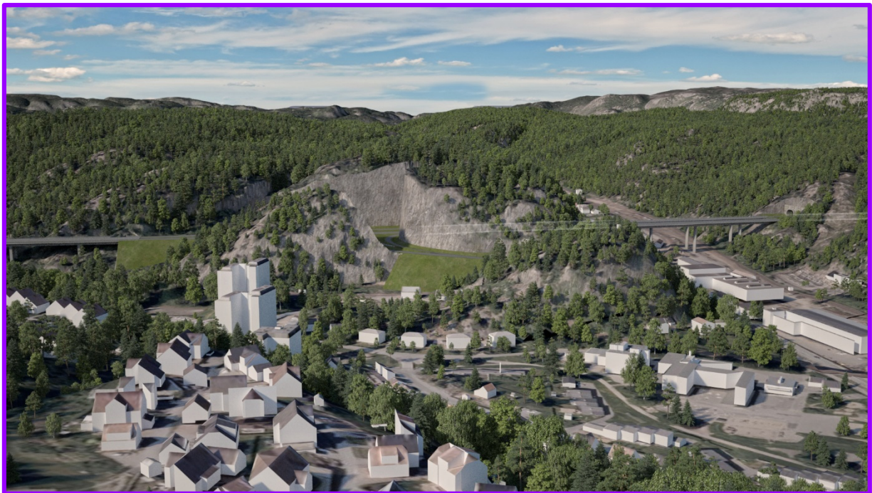
Figur 26: Lilla korridor ved rv. 9, sett mot nord
