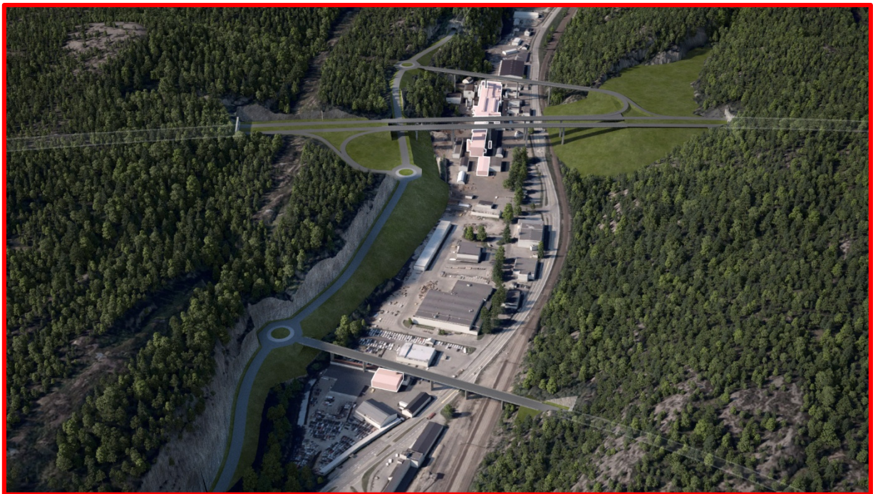
Figur 35: Rød korridor ved rv. 9, sett mot nord
