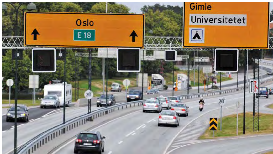
Kapasitetsøkningen på strekningen E 18 Kvadraturen-Randesund må forseres på grunn av stor trafikkøkning.
