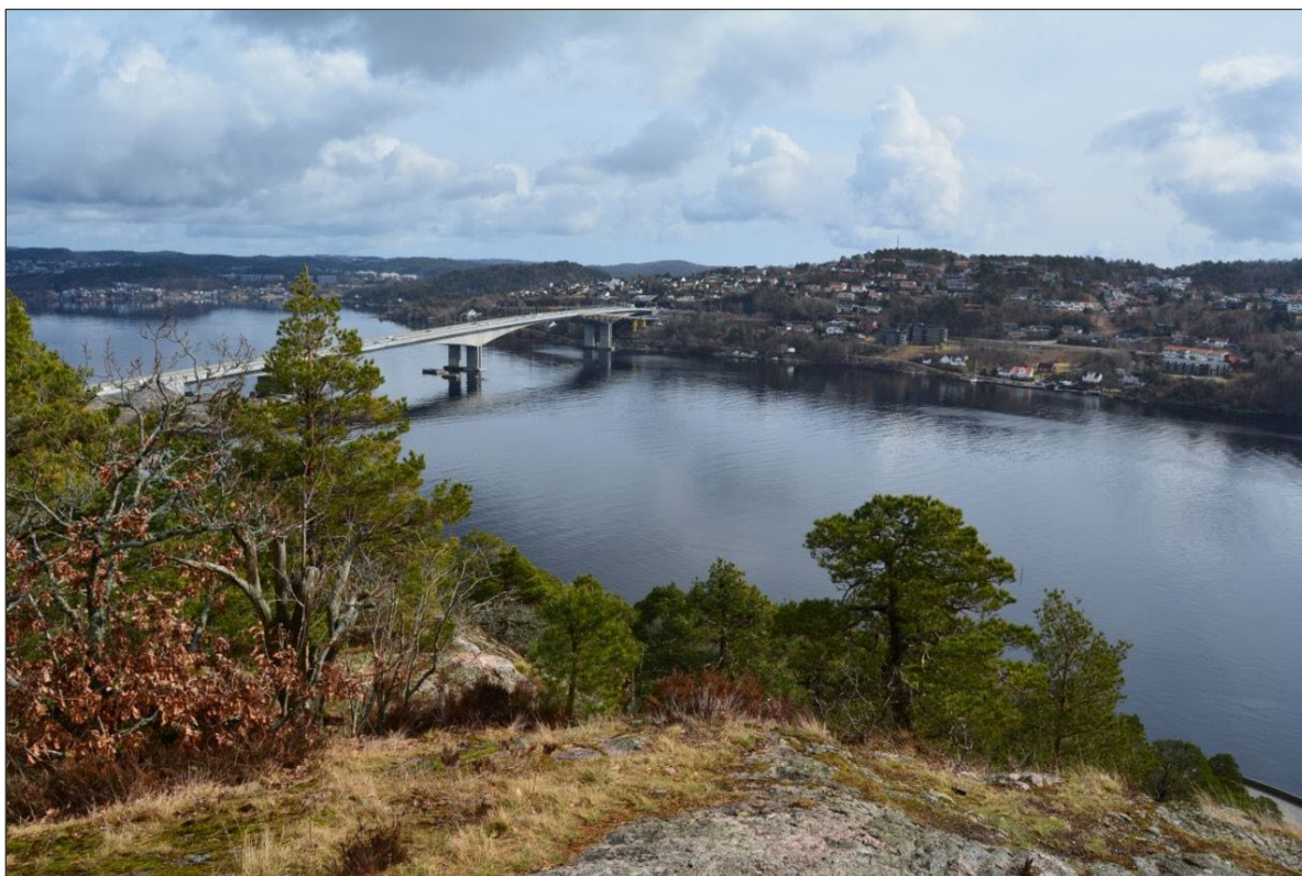
Figur 14: Utsikt fra toppen av Ringknuten mot nordøst. Varoddbroa (E18) og Sømslandet i bakgrunnen.
