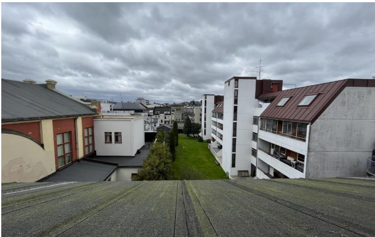
Figur 8: Bilde fra 4. etasje i Holbergs gate. Østre Strandgate 49/51 er til høyre.
