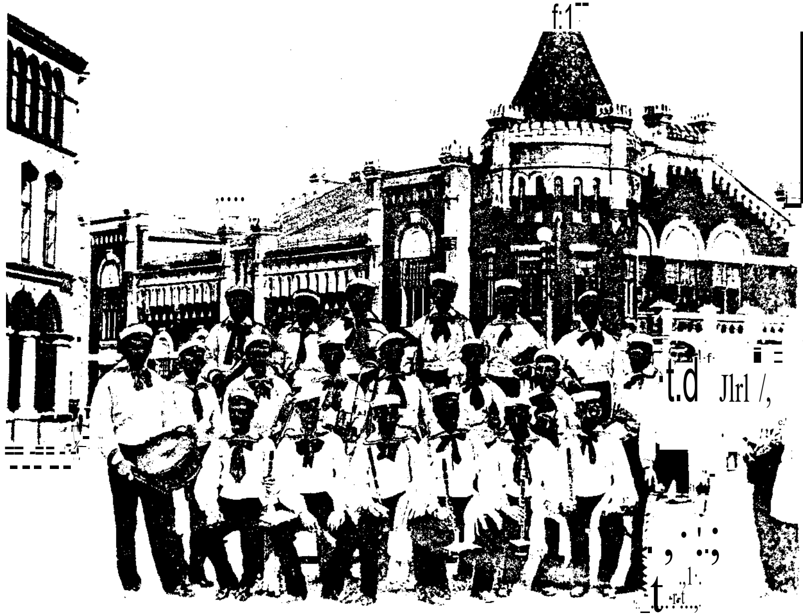
Kristiansand Turnhall med Turnforeningens Musikkorps i 1902 (bilde-montasje). Legg merke til gesimsavslutning med tårn og krenellering og balkongen på høyre side.
