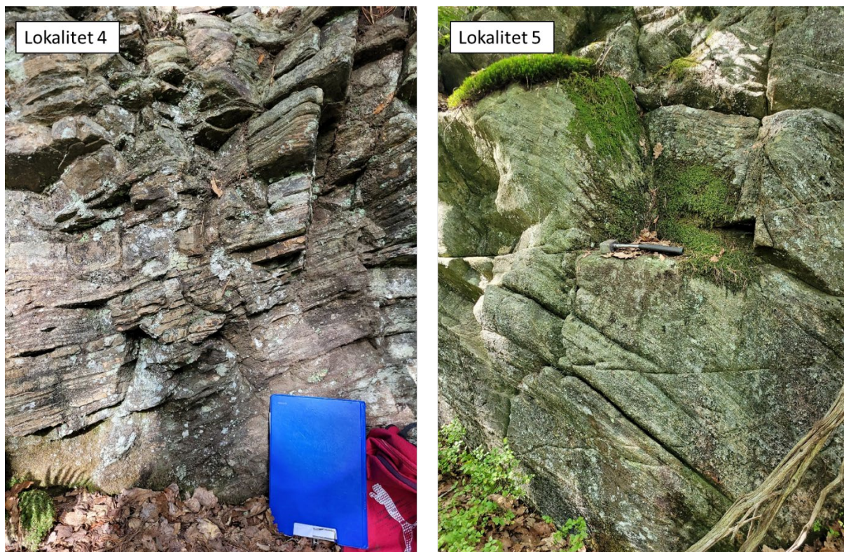
Figur 2-6: Forvitrede bergarter med oppsprekking langs foliasjonen og på tvers av foliasjonen.
