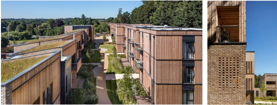
Leilighetsbygg med god helhetlig utforming, hvor oppbrytning i mindre volumer og kombinasjon av flere materialer bidrar til å nedskalere volumene, Clock House Gardens, Stockwool Arkitekter
