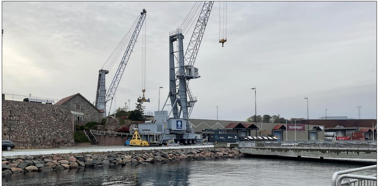
Figur 4. Planområdet er i hovedsak planert til havneformål. Eneste rest av opprinnelig terreng ses mellom to kraner midt i bildet (Foto: Rambøll).
