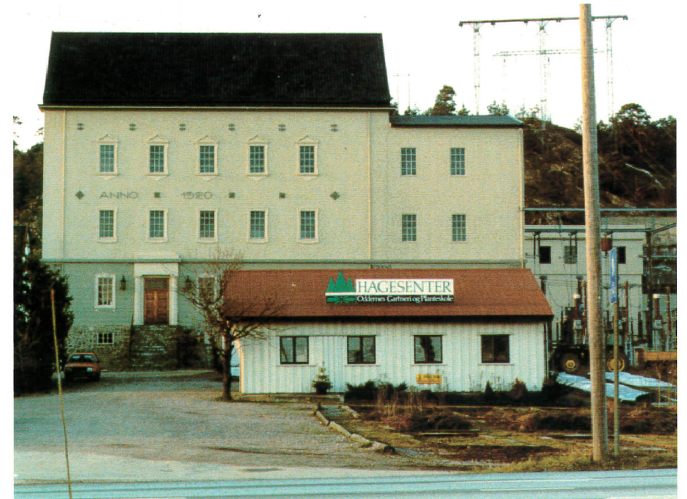
Lund sekundærstasjon, bygget 1920
