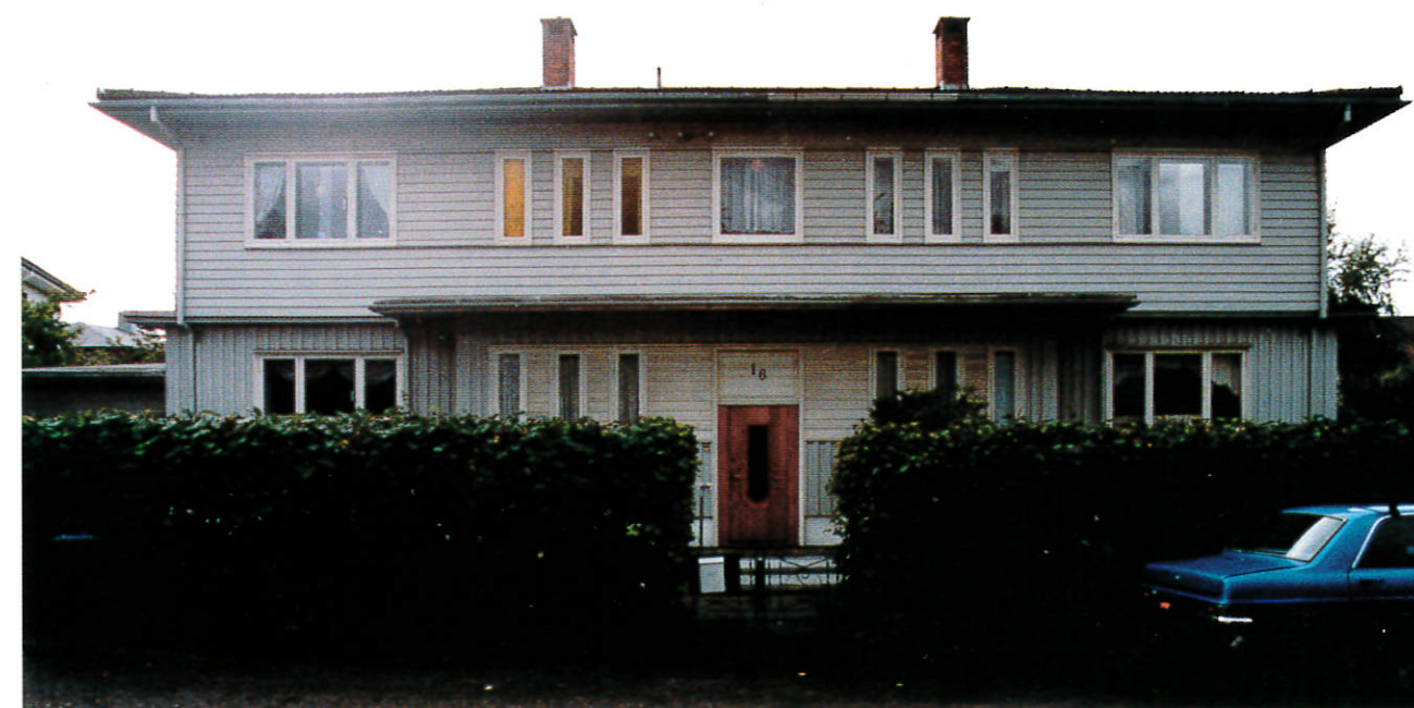
Flaten 16, tremanns bolig som sto ferdig i 1939, tegnet av Thilo Schoder
