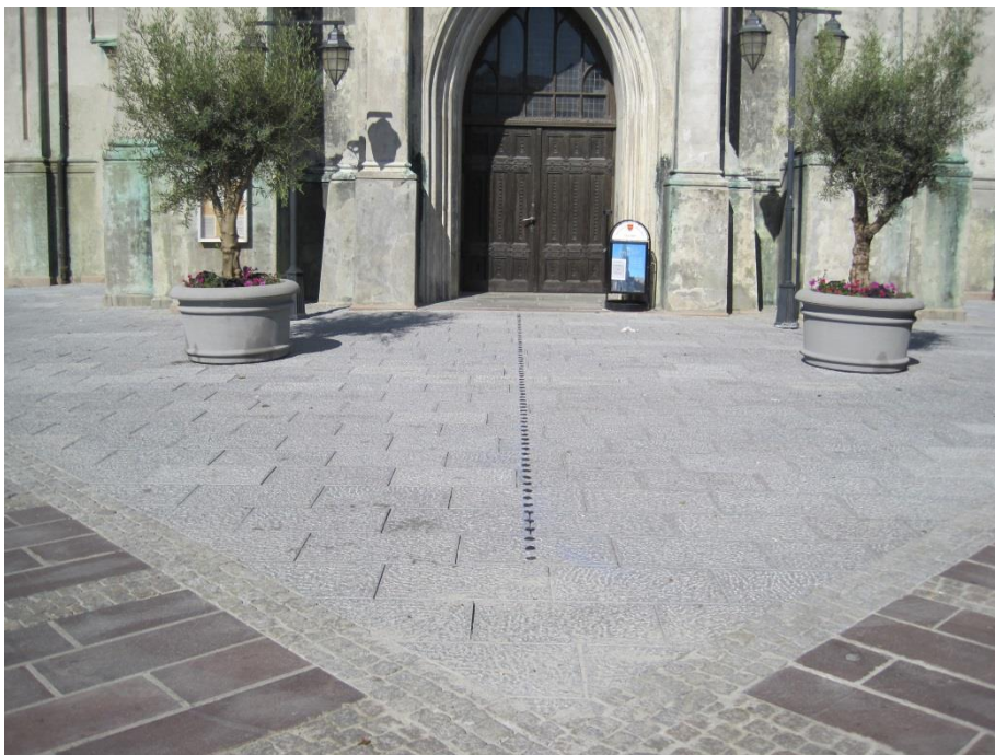
Nytt inngangsparti 2010 ved Domkirka; terskelfritt granittdekke og enkel ledelinje til dør . Foto: Helmer Espeland
