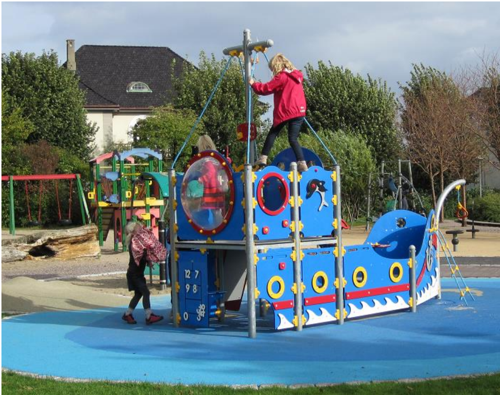
Detalj: Fallunderlag av plasstøpt gummi, tilgjengelig for bevegelseshemma og med kantsikring mot plenen. (Tresse). Foto Tone H Trelsgård
