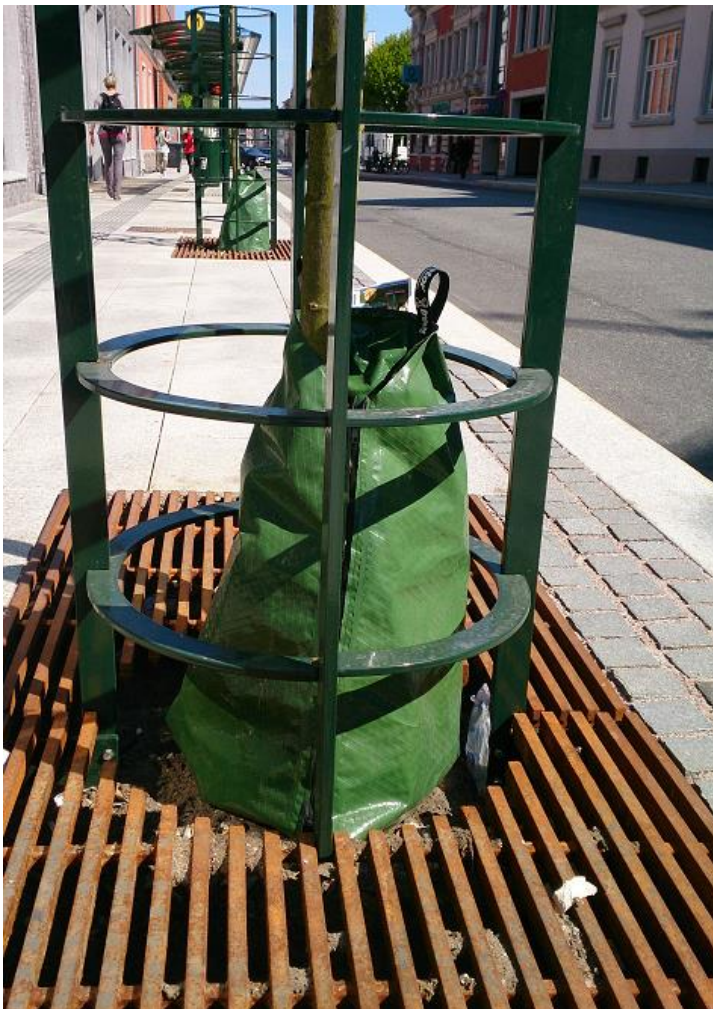
Eksempelbilde: Alle treplantinger i veianlegg og grøntanlegg skal ha vanningssekk! Foto: Helmer Espeland
