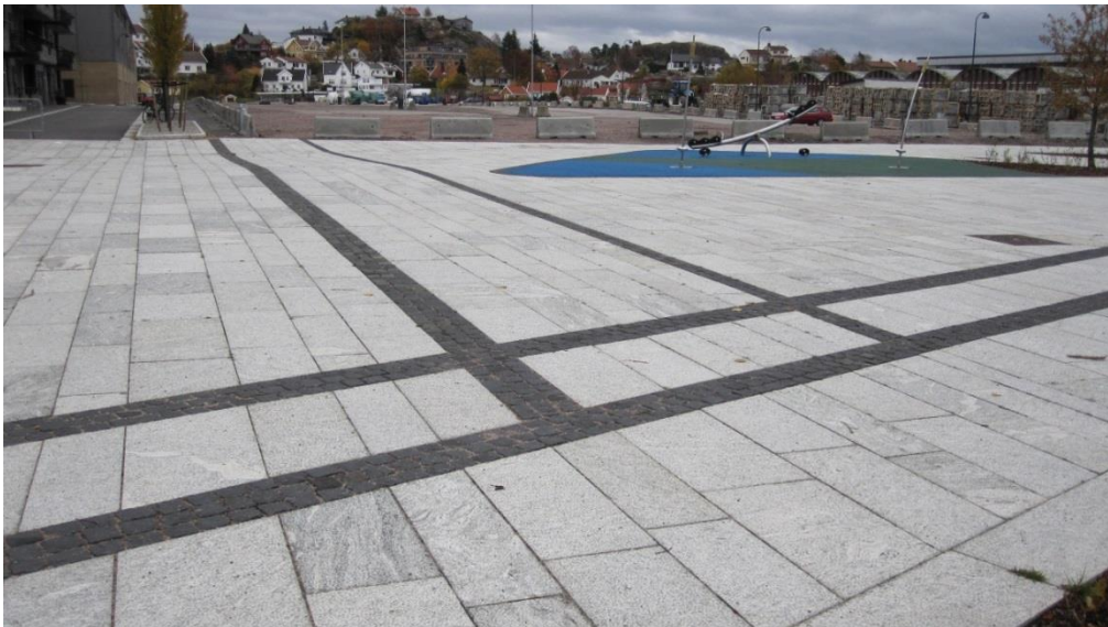
Plassdekke i granitt, fall 2%, ledefelt i mørk smågatestein, (Tangen 2009) Foto Helmer Espeland
