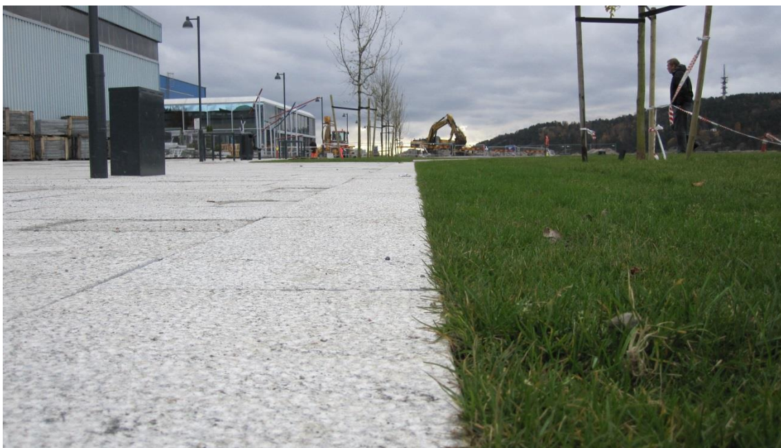
Bilde: Vei med granittdekke, der ytterste rad er støpt fast som kantstein i plan, og med drenering til sideterreng. (Tangen 2009) Foto: Helmer Espeland
