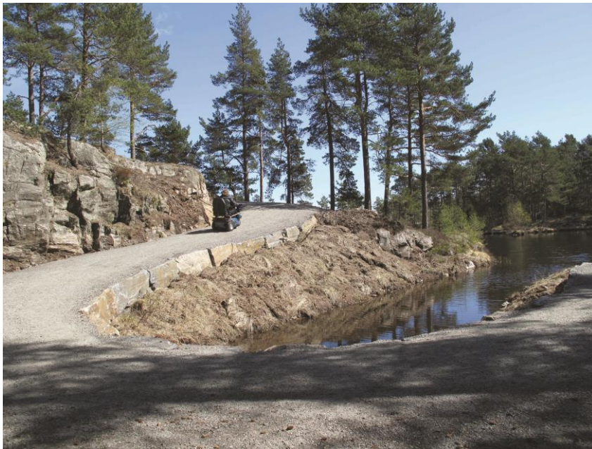
Turvei i Baneheia, anlagt 2009. Bredder 2 m. og stigning 1:12 i bakken på bildet. Foto: Per Svein Staalesen.
