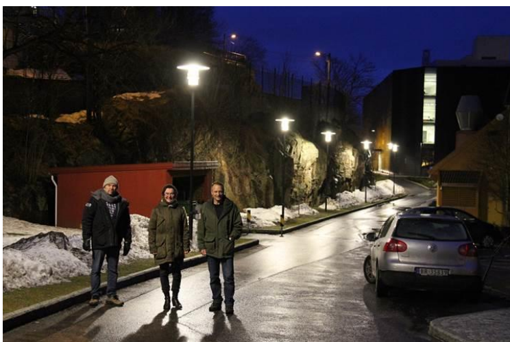
Bilde fra belysningsprosjekt 2014; «Godt og trygt lys der du går og sykler». God ansiktsgjenkjenning over det meste av strekningen, og godt opplyst sideterrang og smug Foto: Svein Tybakken, Kristiansand kommune.
